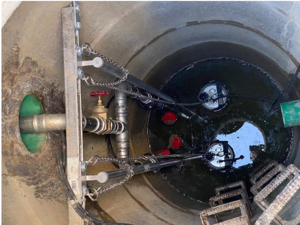
*Bild 3: Eine Doppelanlage MultiDrain UV 625 Schmutzwasserpumpen am Gleitrohrsystem im Beton-Außenschacht*
