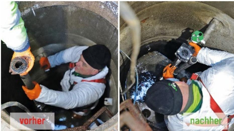
*Bild 2: Ausbau der alten Schachteinbauten, welche aufgrund von Korrosion und Ablagerungen durch das neue Einbauset DN 40 ersetzt werden.*
