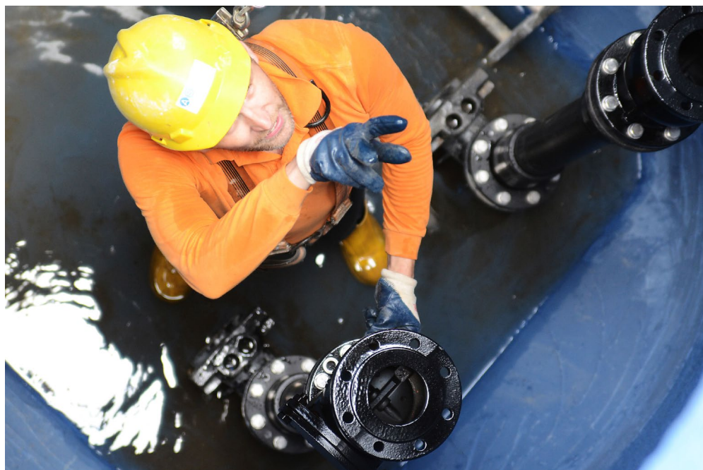
Sanierung und Optimierung von Abwassersystemen
