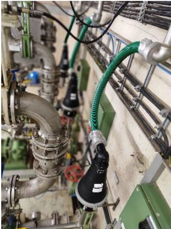
Bild 4: Be- und Entlüftungsventile entfernen eingeschlossene Luft aus Leitungen und lassen bei Unterdruck kontrolliert Luft einströmen.
