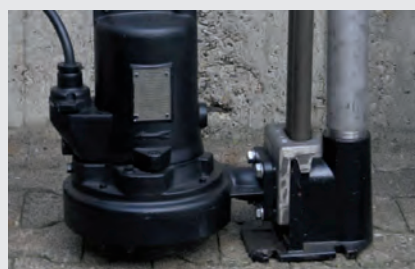
Accoupler la pompe au tube coulissant
