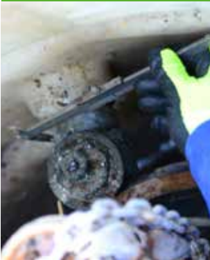
► Pomiar średnicy rurociągu tłoczego
