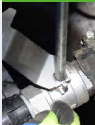
► Instalacja uchwyty zaworu odcinającego
