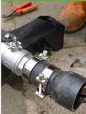
► Zabudowanie połączenia elastycznego
