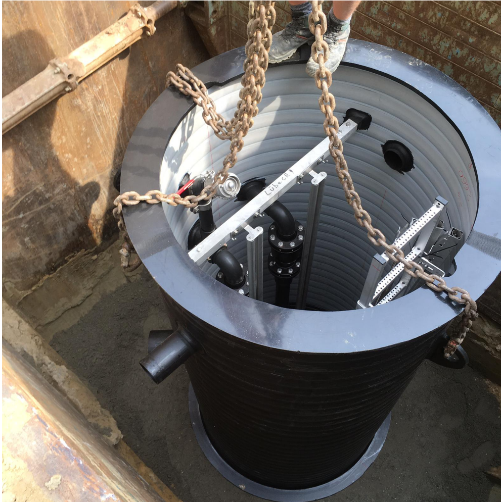
Bild 3 (Grothe Bau GmbH & Co.KG): Der mit Leiter, Gleitrohrsystem und Druckrohren vormontierte PKS-Schacht wird in die vorbereitete Baugrube versetzt. Die Pumpen werden später mit Ketten an den Gleitrohren heruntergelassen.
