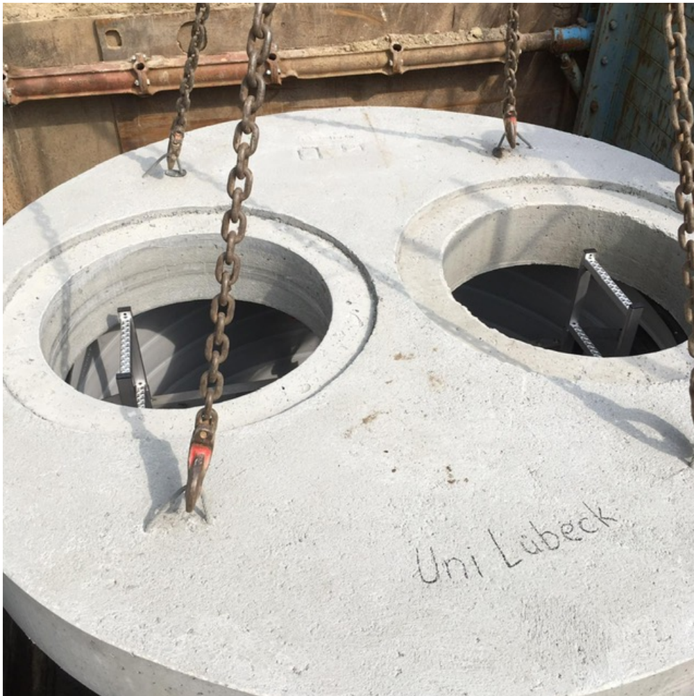
Bild 5 (Grothe Bau GmbH & Co.KG): Die Abdeckplatte Klasse B wird auf das chmutzwasserpumpwerk versetzt
